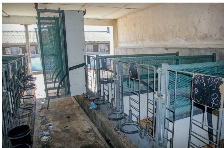
Výklopné hrazení v krytém teletníku se osvědčilo
