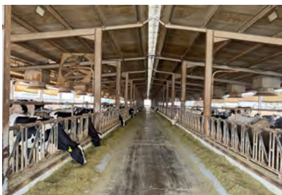
Produkční stáje NDF s chladicím systémem Colar Cooling
