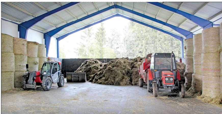
Pod jednou střechou je i hnojiště, které zakončuje stáj v jednom ze štítů
