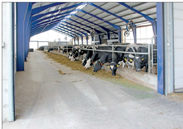
Pohled od štítu s hnojištěm přes vrata do krmné chodby, patrné je prosvětlení stěn
