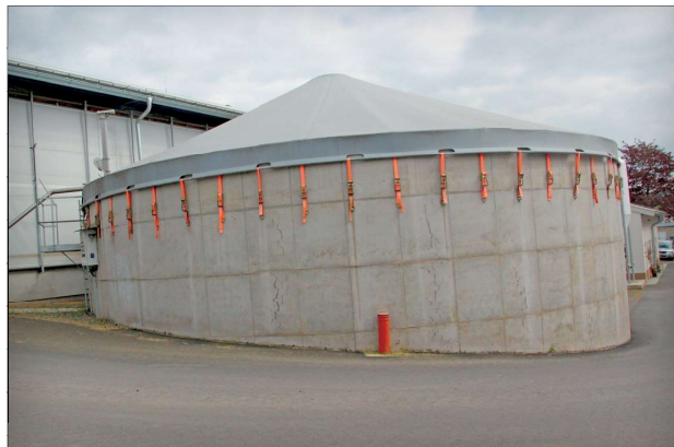
Vedle stáje vyrostla i jímka na odpadní vody a hnojívku
