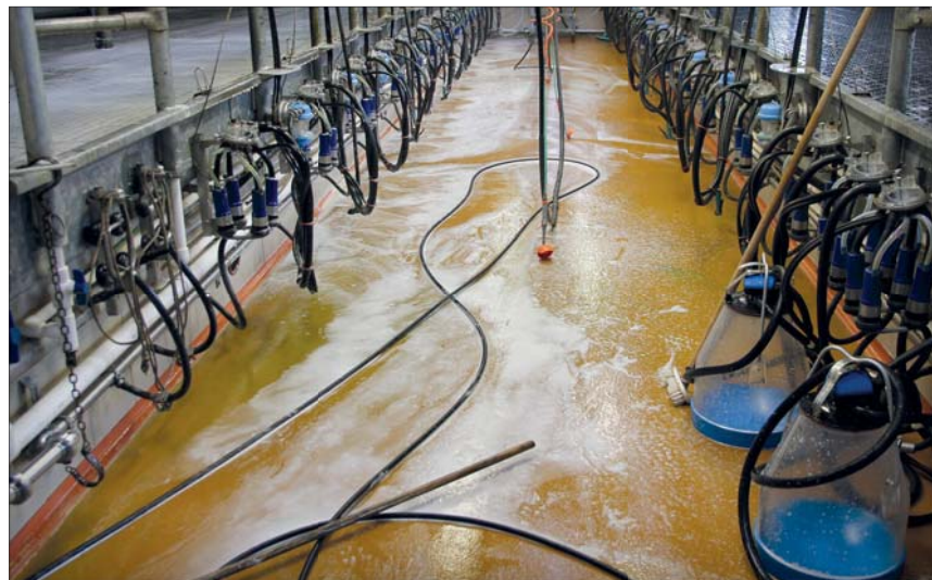
Dojírna 2 x 12 se zrychleným odchodem v Hejnicích doplněná o systém Afífarm
