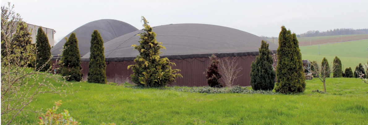
Bioplynová stanice o výkonu 500 kW na provoz farmy plně postačuje
