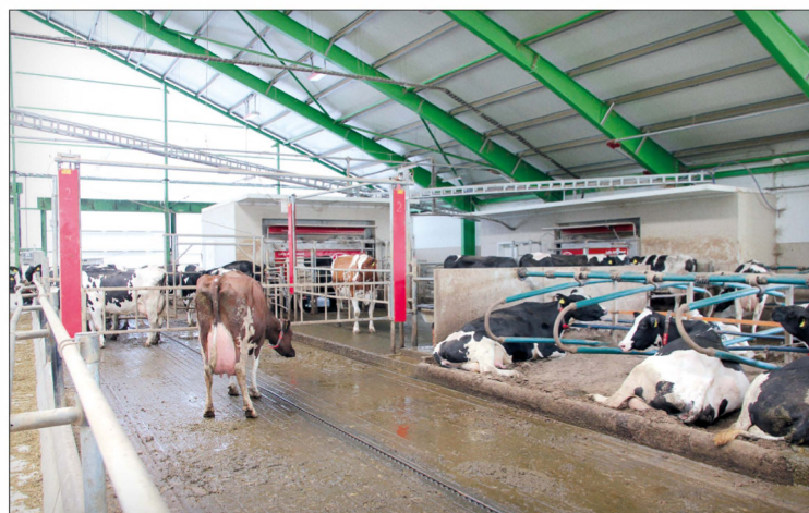
Stáj je vybavena nejmodernější technologií včetně typů chytrých zábran, robotického přihrnovače krmiva, ventilátorů a podobně, boxy jsou třikrát týdně stlané separátem
