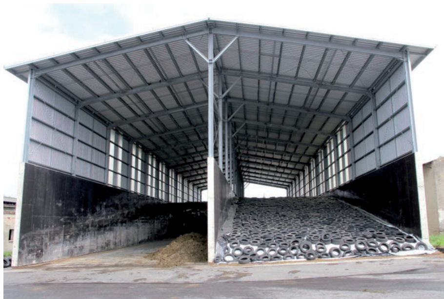
Všechny silážní žlaby jsou v ZP Ostrov zastřešené
