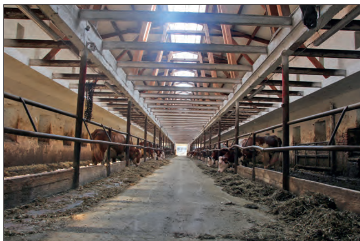
Prosvětlení a zvýšení kubatury stáje se v Oldřiši povedlo
