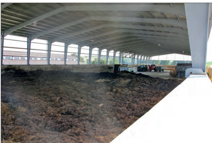
Kryté hnojiště s ocelovou konstrukcí se podařilo vybudovat v posledních letech
