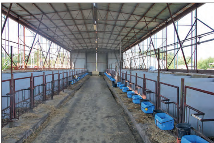
Úspěšná adaptace plechového přístřešku na teletník
