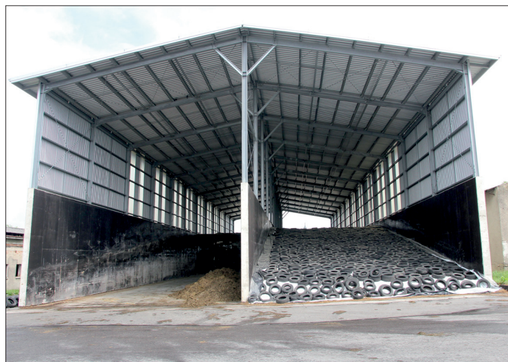
Všechny silážní žlaby jsou v ZP Ostrov zastřešené
