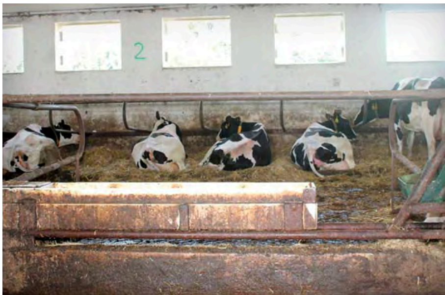
Požadovanou výměnu vzduchu ve stáji chovatelé zajistili vybouráním oken
