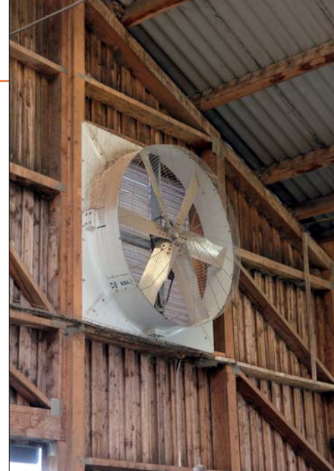
Štítý stáje jsou rovněž odvětrávané
