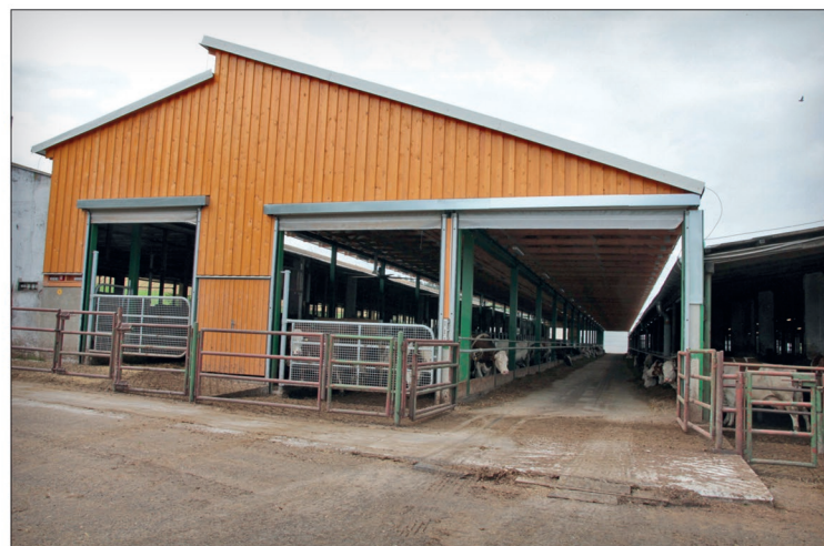
Mezi dvě stáje se včlenil nový zastřešený prostor vybavený částečně boxy a částečně jej tvoří krmná chodba a krmný stůl
