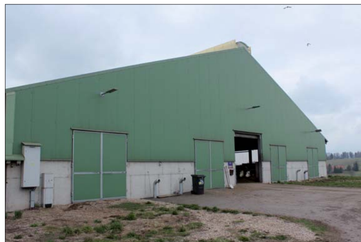
Pohled na stáj – vjezd na krmný stůl
