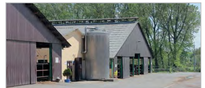
Ukázkový areál farmy v Rosicích, před dojírny je venkovní chladič nádrž
