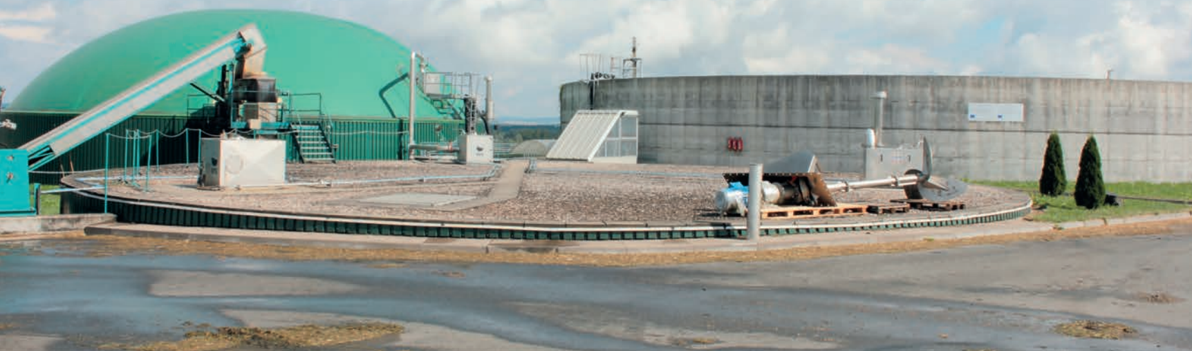
Bioplynová stanice technologicky dobře navazuje na živočišnou výrobu
